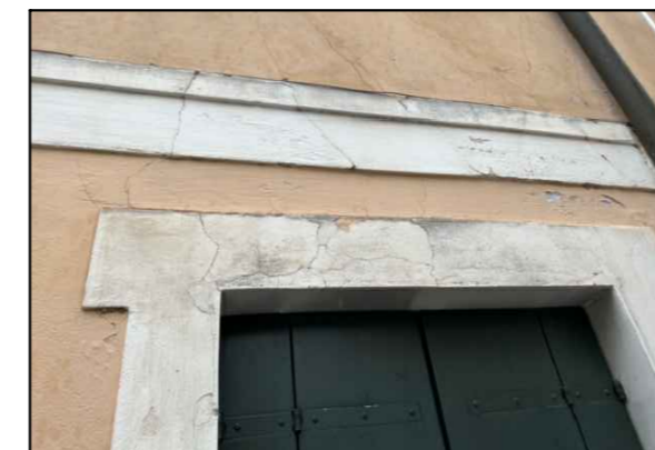
MARCAPIANI DI INTONACO TINTEGGIATO INTERVENTO: INTEGRAZIONE CON STUCCATURE E RITINTEGGIATURA TIPO "CALCE DEL BRENTA" CASHMERE 5048
