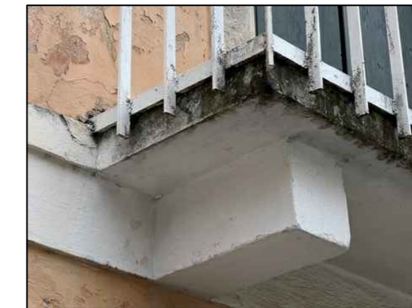
BALCONCINO IN CALCESTRUZZO ARMATO INTERVENTO: PULIZIA CON IDROLAVAGGIO, RITINTEGGIATURA TIPO "CALCE DEL BRENTA" CASHMERE 5048
