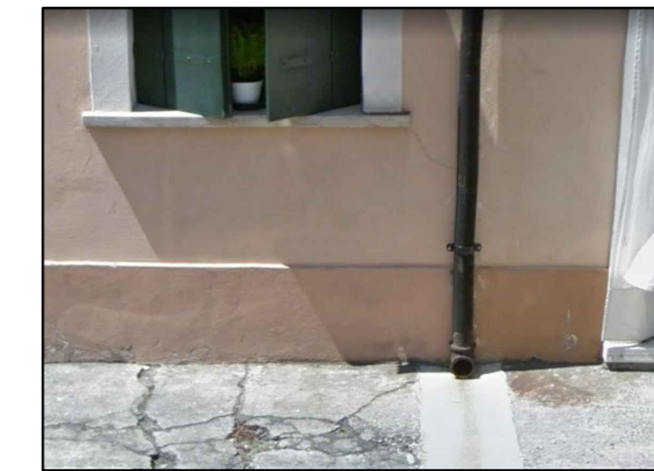
BASAMENTO DI INTONACO TINTEGGIATO INTERVENTO: INTEGRAZIONE CON STUCCATURE E RITINTEGGIATURA TIPO "CALCE DEL BRENTA" POLVERE 5050
