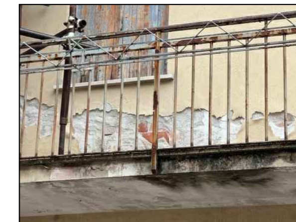
BALCONE IN CALCESTRUZZO ARMATO INTERVENTO: PULIZIA CON IDROLAVAGGIO, RITINTEGGIATURA TIPO "CALCE DEL BRENTA" CASHMERE 5048
