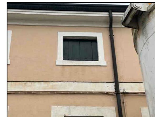
CORNICE E DAVANZALE FINESTRE PIANO SECONDO DI INTONACO TINTEGGIATO INTERVENTO: INTEGRAZIONE CON STUCCATURE E RITINTEGGIATURA TIPO "CALCE DEL BRENTA" CASHMERE 5048
