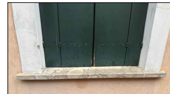
DAVANZALE IN MARMO TIPO BOTTICINO INTERVENTO: PULIZIA, CONSOLIDAMENTO, INTEGRAZIONE CON STUCCATURE
