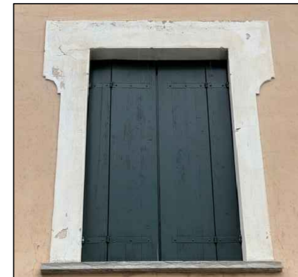
CORNICE DELLE FINESTRE INTONACO TINTEGGIATO INTERVENTO: INTEGRAZIONE CON STUCCATURE E RITINTEGGIATURA TIPO "CALCE DEL BRENTA" CASHMERE 5048
