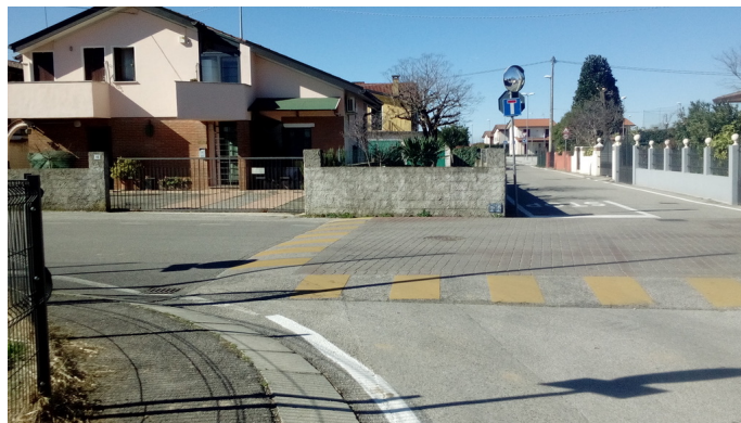
Piattaforma rialzata a Facca in via della Roggia (assenza di continuità pedonale)
