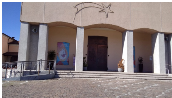
Chiesa, Facca con rampa di accesso
