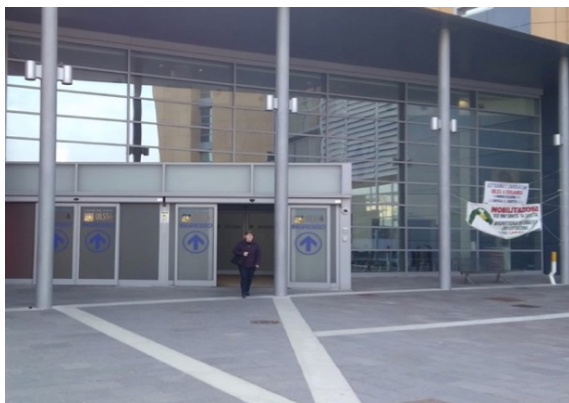
Ingresso principale ospedale con porte automatiche
