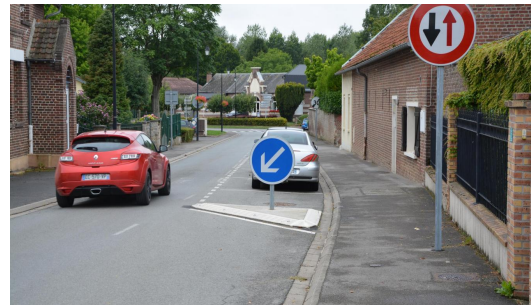
Es. di interventi di trattamento degli ingressi: chicane, restringimenti carreggiata, segnaletica
