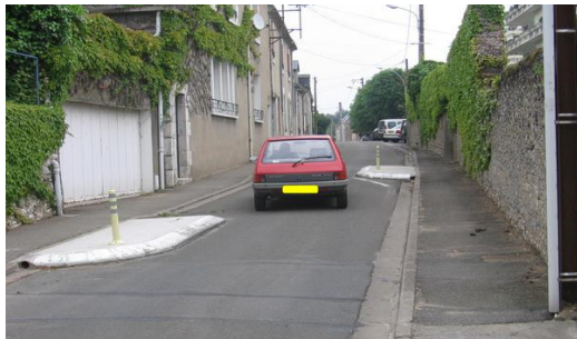
Es. di interventi di trattamento degli ingressi: chicane, restringimenti carreggiata, segnaletica
