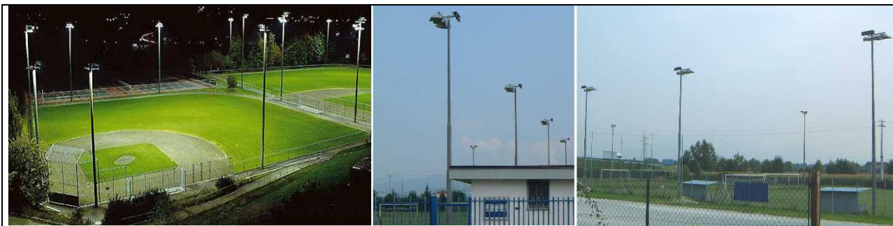
Figura 2.10 - Impianti sportivi illuminati in modo conforme alla L.R. 17/09 con proiettori asimmetrici orientati orizzontalmente e che non disperdono luce verso l'alto.
