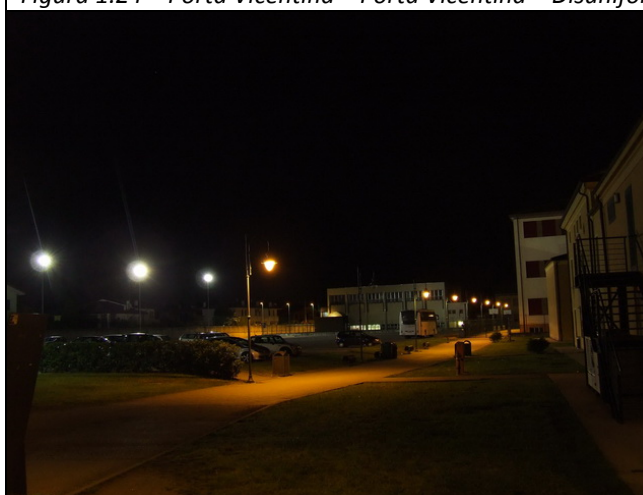
Figura 1.25 – Via Riva dell'Ospedale – Pedonale e parcheggio – Corpi illuminanti abbaglianti con limitati livelli di confort visivo.
