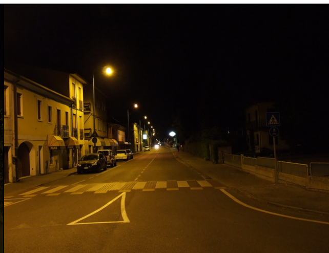
Figura 1.28 – Via Borgo Bassano – Illuminazione corretta ed uniforme
