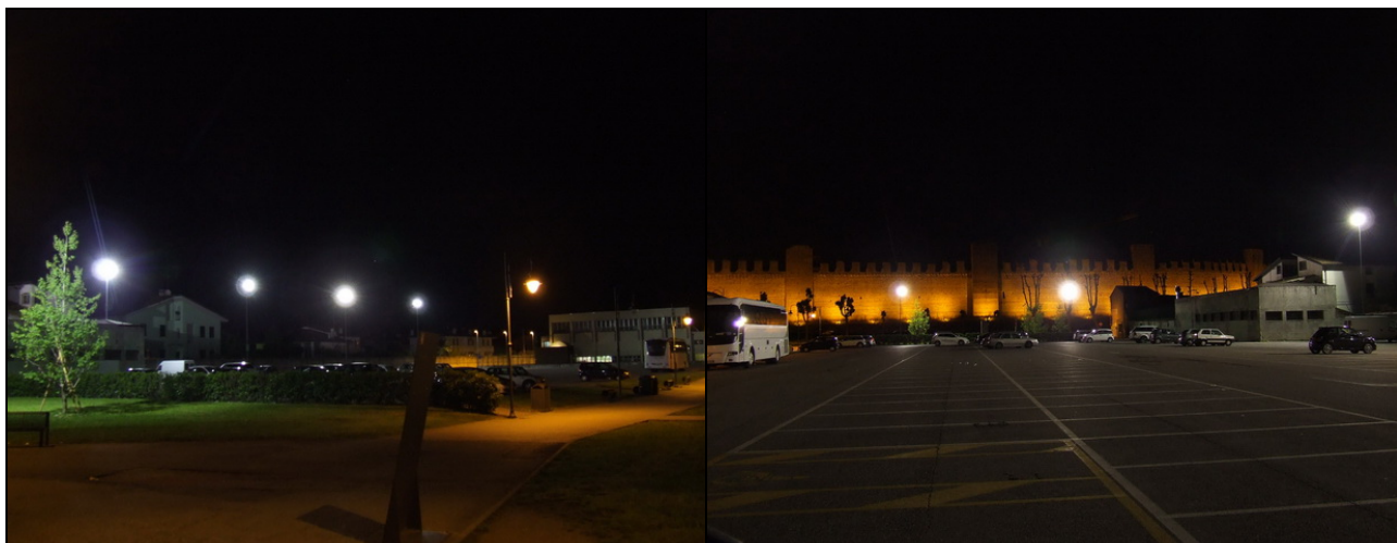
Figura 1.26 – Via Riva dell’Ospedale – Parcheggio – Illuminazione fortemente abbagliante e fortemente disuniforme fra zone in prossimità dei proiettori e aree distanti.
