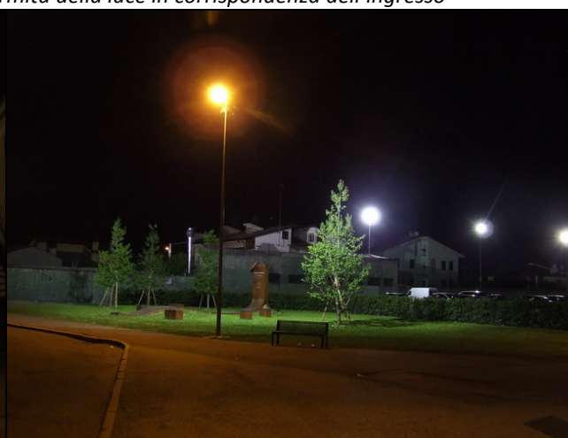
Figura 1.25 – Via Riva dell'Ospedale – Pedonale e parcheggio – Corpi illuminanti abbaglianti con limitati livelli di confort visivo.
